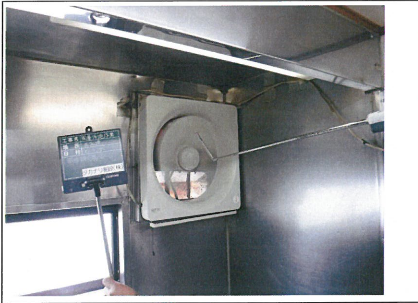
④厨房換気扇 風速測定中
