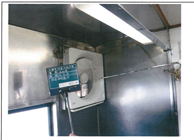
④厨房換気扇 風速測定中
